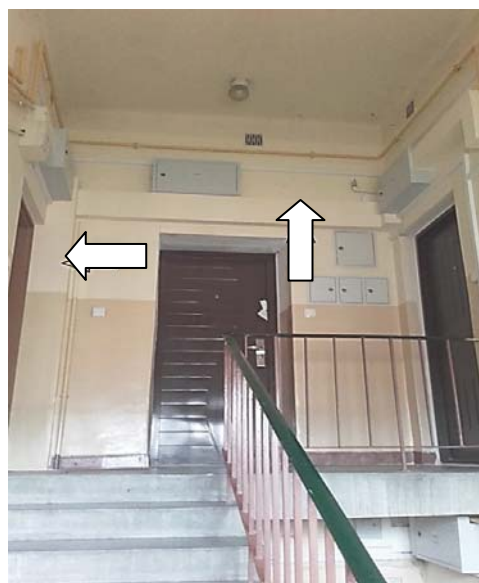
Instalacja w klatce schodowej Pułk. Nullo 19 po zabudowie
